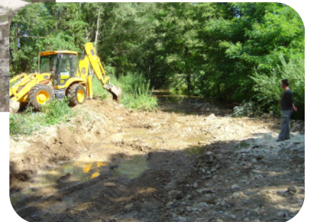
Travaux en cours d'eau
