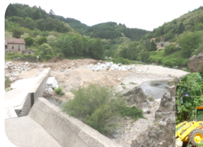
Aménagement d'un site de baignade
